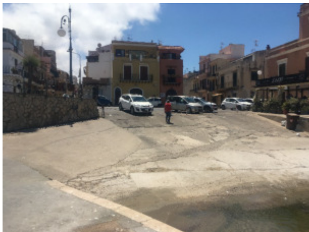
Figure 7 - Vista del scalo di alaggio che ospita il mercato del pesce
