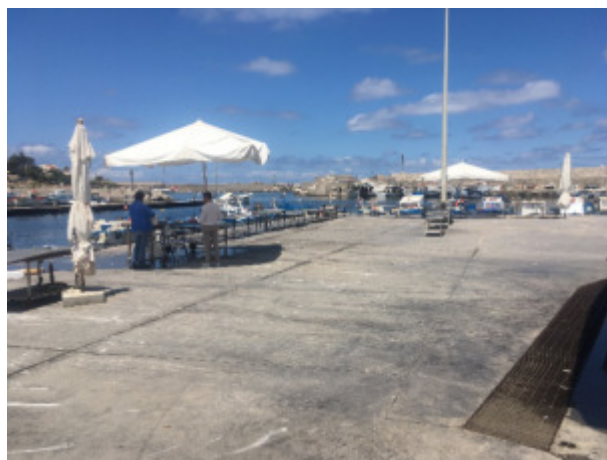
Figure 5 - Vista del scalo di alaggio che ospita il mercato del pesce
