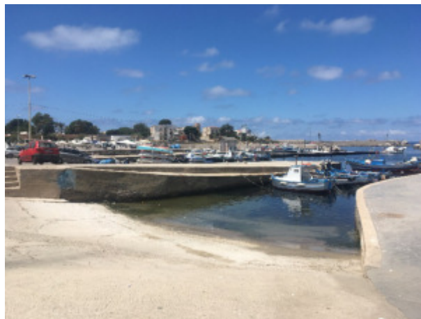
Figure 8 - Vista del scalo di alaggio che ospita il mercato del pesce
